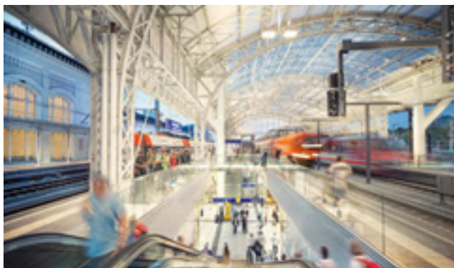
Glavni željeznički kolodvor
